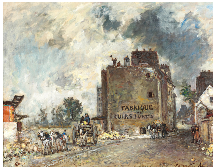
Demolition work in Rue des Franc-Bourgeois St. Marcel (1868) Kunstmuseum Den Haag
